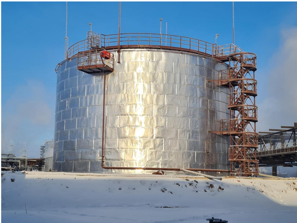
Мазутный бак ТЭЦ-2 объемом 3000м 3
