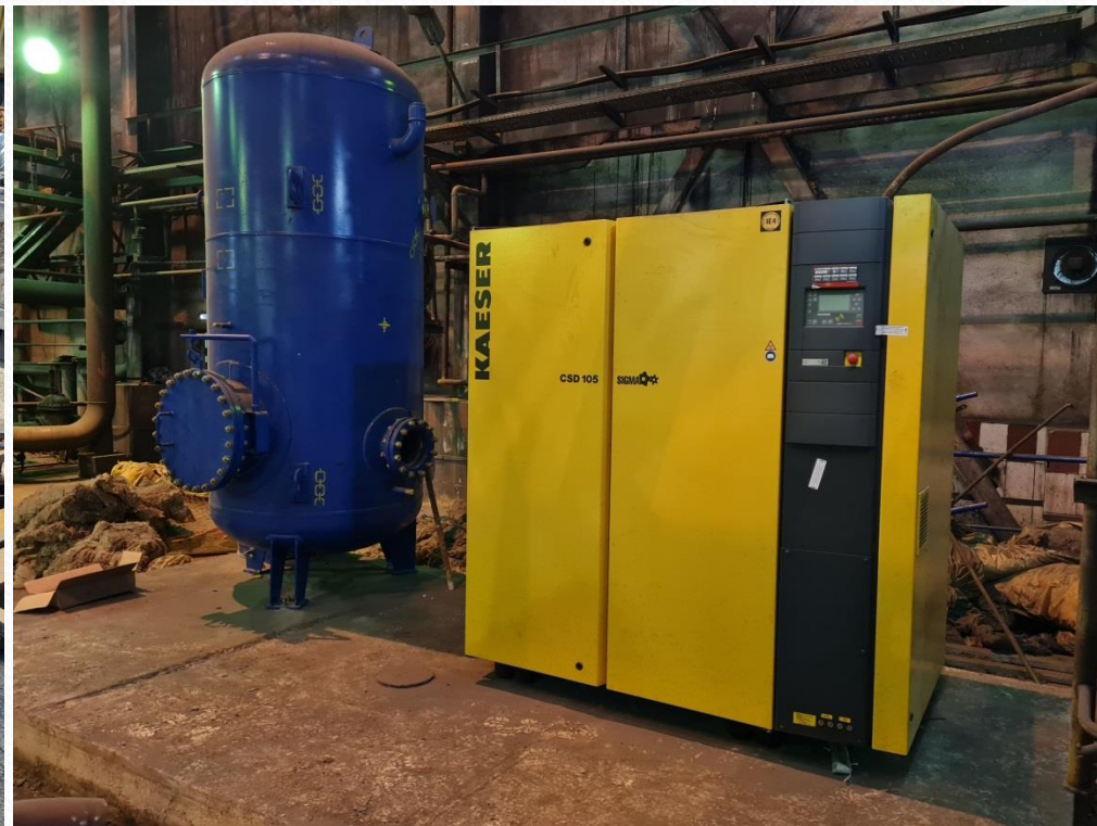
Винтовой компрессор 7,5 бар
